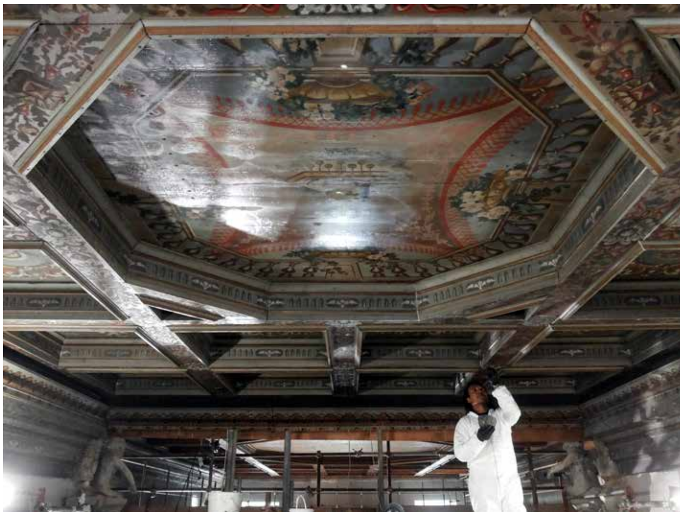
Ripristino del cassettonato dentro la chiesa e ultime fasi di ritocco e stuccatura.
