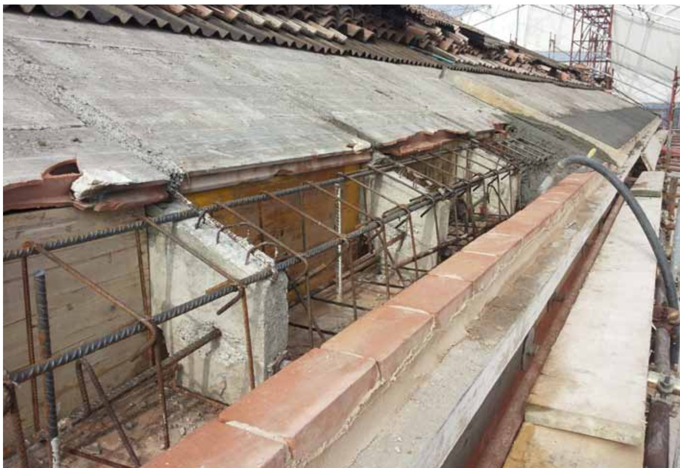
Lavori in messa di sicurezza del tetto della chiesa
